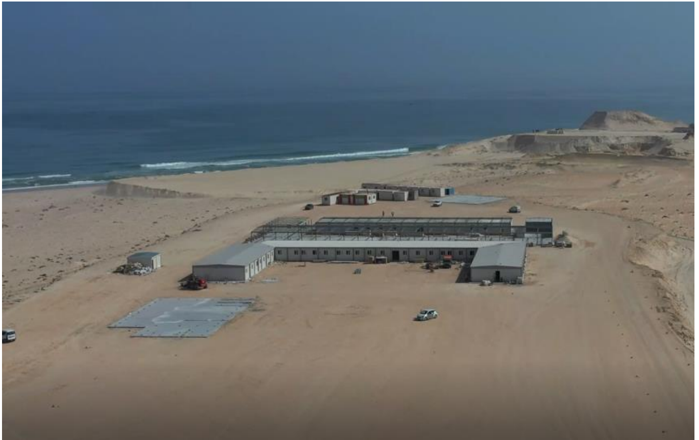
Figure 3 : Photo du chantier au 30/05/2022
