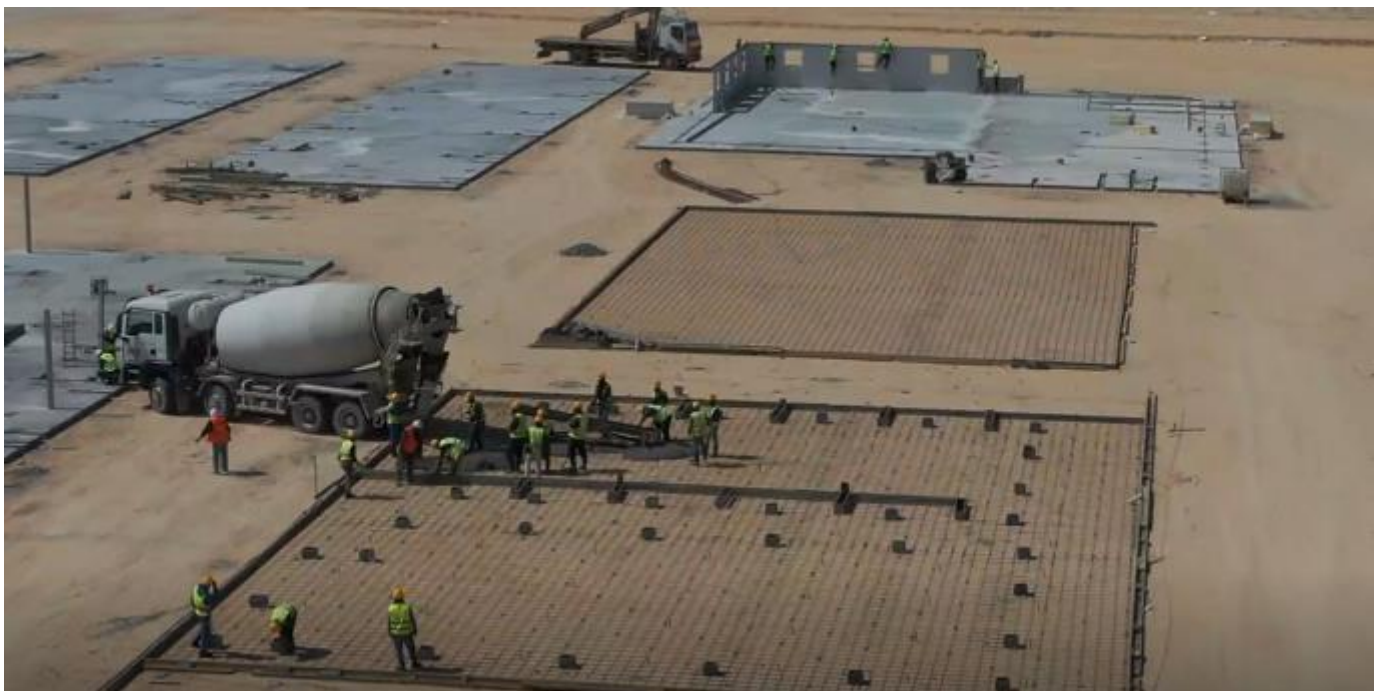
Figure 4 : Travaux d'installation du chantier
