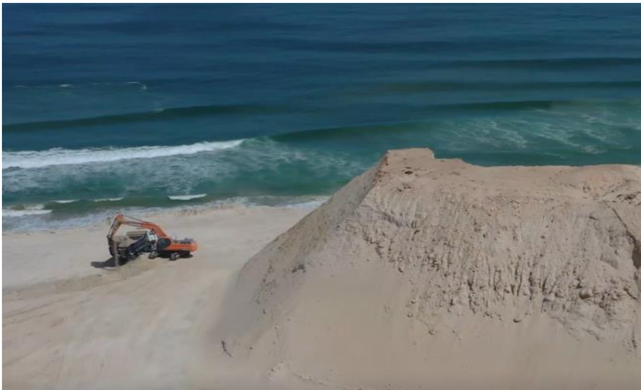
Figure 5 : Travaux de terrassement
