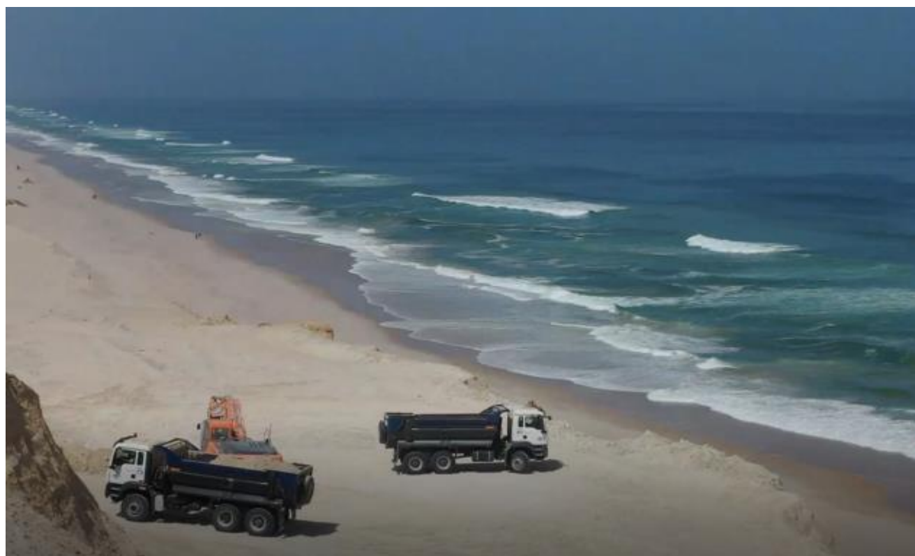
Figure 6 : Travaux de terrassement
